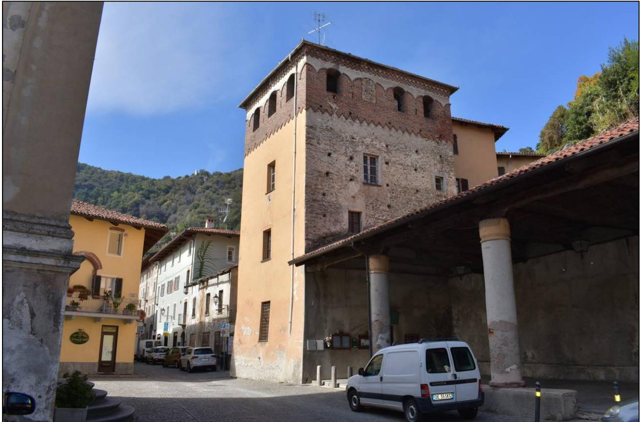
Le aperture, principalmente a sezione rettangolare, nella tromba scale assumo la forma ad arcata, mentre nel sottotetto sfruttano la vecchia merlatura a cui sono appoggiati archi di trasferimento delle spinte delle strutture di copertura soprastanti. Due di queste ultime aperture risultano tamponate per permettere l'una il passaggio di canne fumarie mentre l'altra è probabilmente frutto di un antico intervento di consolidamento strutturale.
