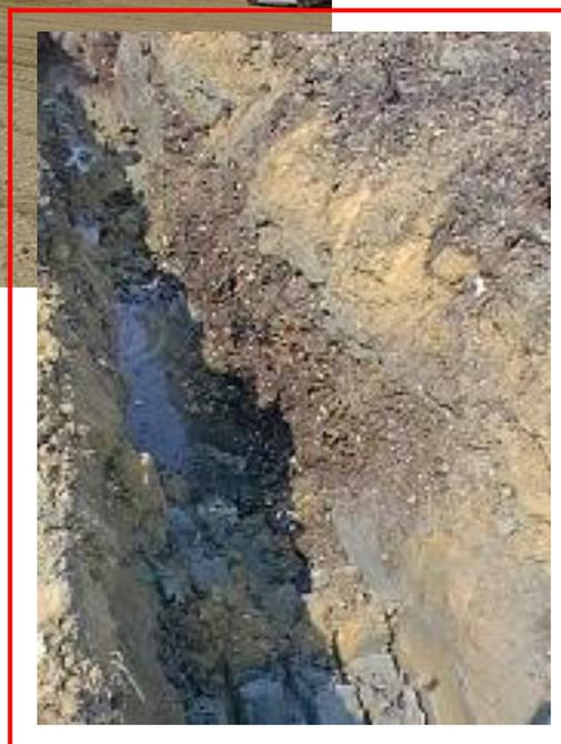
**Veduta dell'area e, nel riquadro, particolare di una delle trincee di indagine con in evidenza i rifiuti costituiti da *fluff* e la quota dell'acquifero.**
