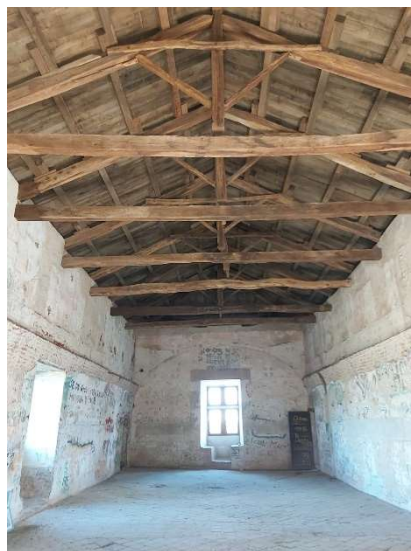
CASTELLO DI CARDE' PECORSO DI VISITA E COPERTURA MANICA NORD
