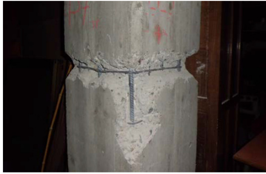
PILASTRO n. 7 - Piano Sottotetto rilievo armature
