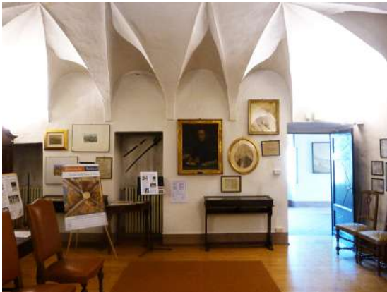
Viste della volta a ombrello presente nella sala adiacente alla Cappella marchionale
